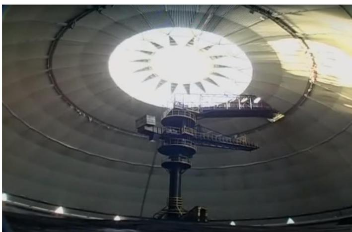
El edificio consta de un área cubierta circular de 105 m de diámetro y 40 m de altura, con unos 10.000 m<sup>2</sup> de superficie. Para su uso museístico tan sólo se deberían retirar los equipos mecánicos innecesarios, aunque con la posibilidad de mantener y aprovechar la máquina apiladora de carbón, y abrir el muro de contención de este mineral para permitir las vistas al mar. También se podría levantar alguna estructura en el interior para un mayor aprovechamiento del espacio.
