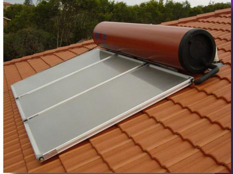
Solar térmica: la energía del sol se aprovecha para calentar agua a través de unos colectores solares. Esa agua tiene después diferentes usos: agua caliente, calefacción, ...
