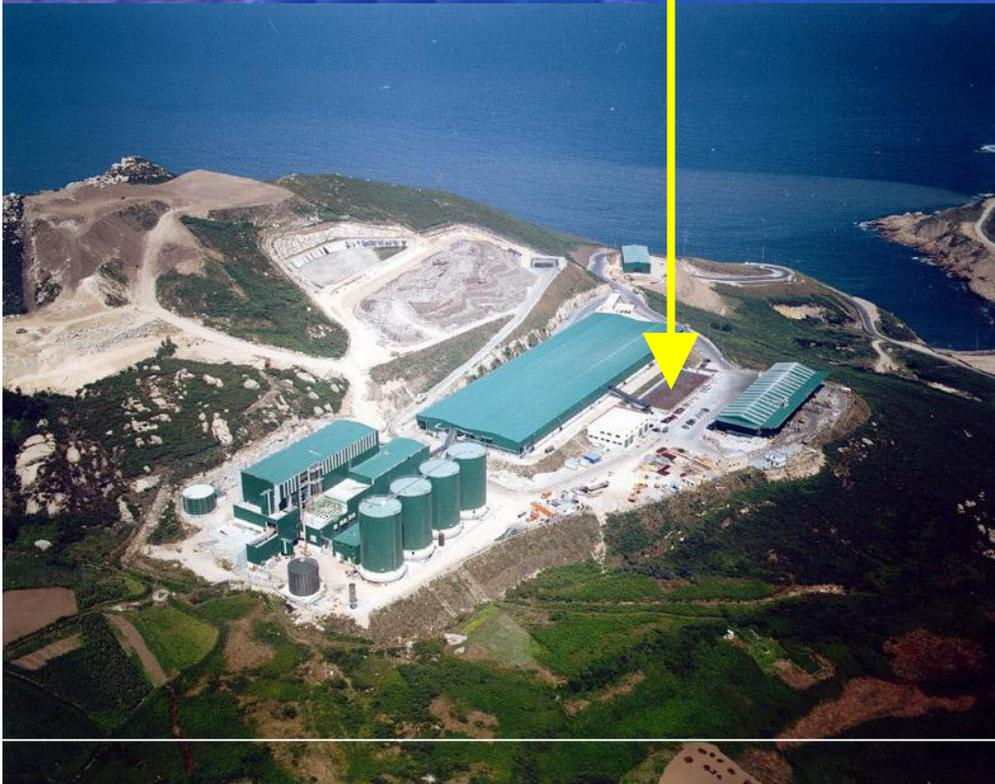
A fin de eliminar cualquier fuga posible de olores este biofiltro, consistente en pedazos de madera y corteza, destruye las moléculas productoras de olor, una vez más gracias a la acción de unas bacterias.
