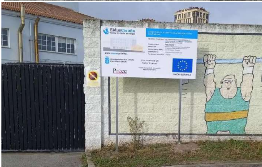
Imágenes del local cedido del Institución Benéfico Social Padre Rubinos para su conversión en centro de acogida de baja exigencia y el cartel provisional de las obras
