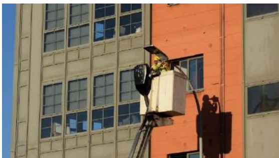
Imágenes de la instalación de las nuevas luminarias
