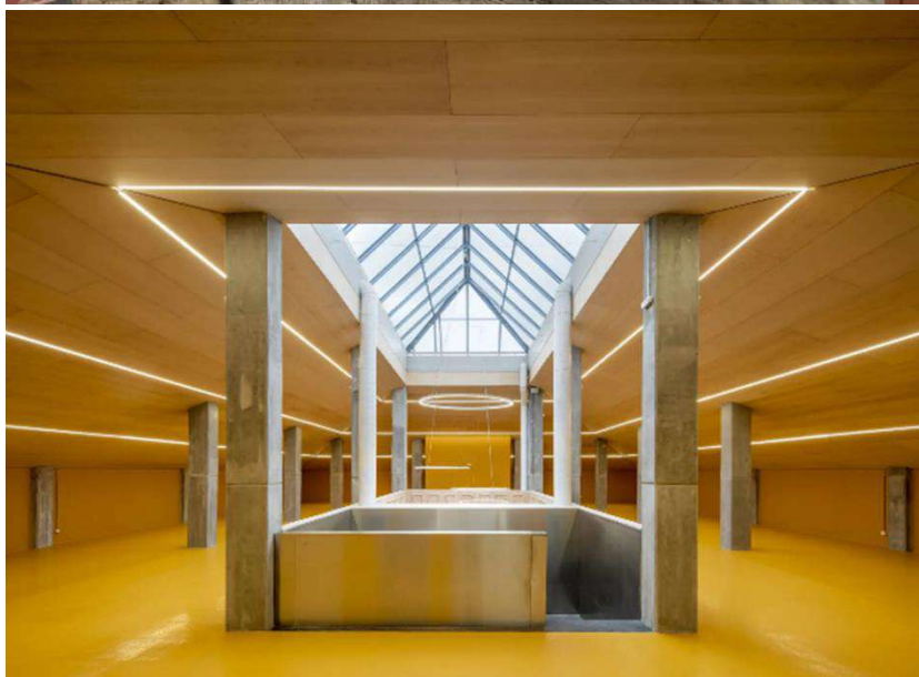
Imágenes de segunda planta del mercado de Adormideras antes en obras y después
