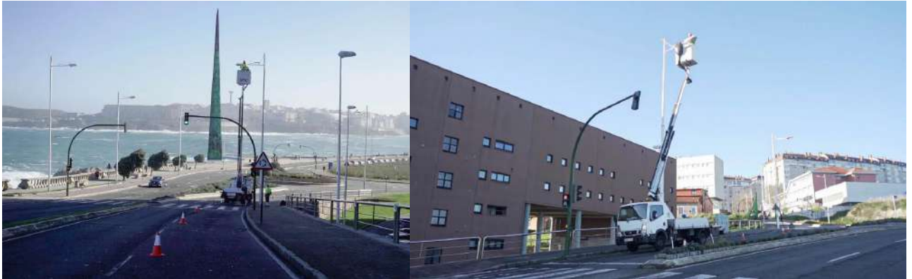
Imágenes de la instalación de nuevas luminarias en la Avda. Gerardo Porto
