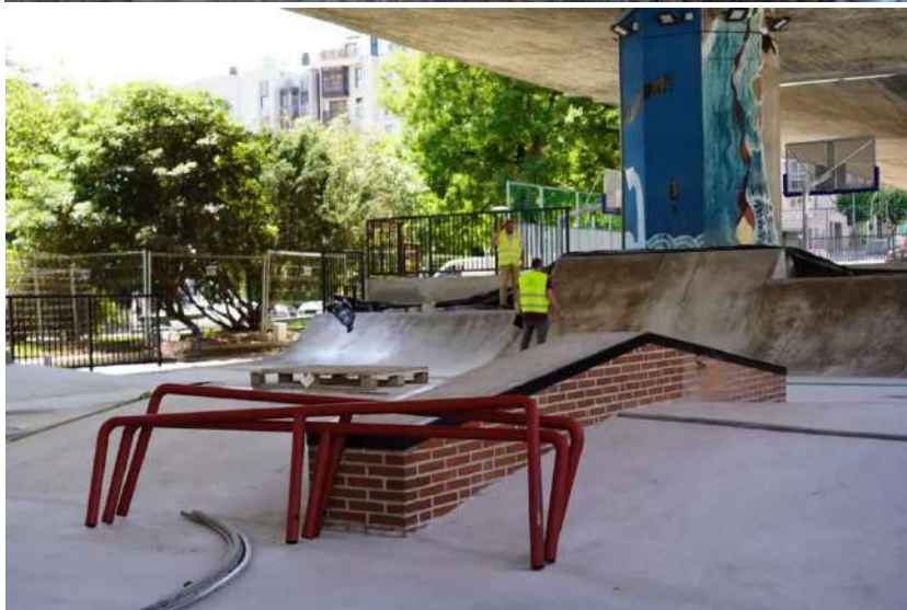
Imágenes durante y después de las obras. Pista de skate
