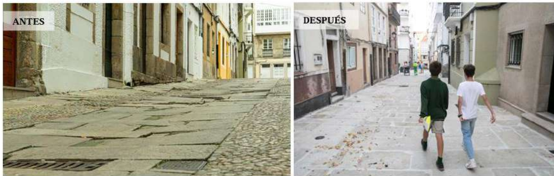
Antes y después de la intervención de la Calle Cortaduría
