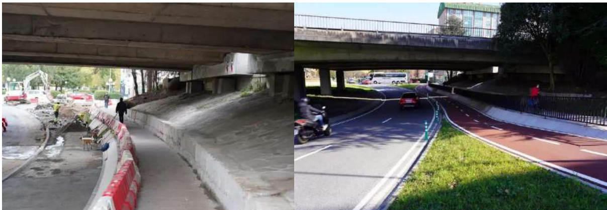
Imágenes del carril bici la glorieta de Elviña y la Avenida de Pablo Picasso. Antes y después de la actuación
