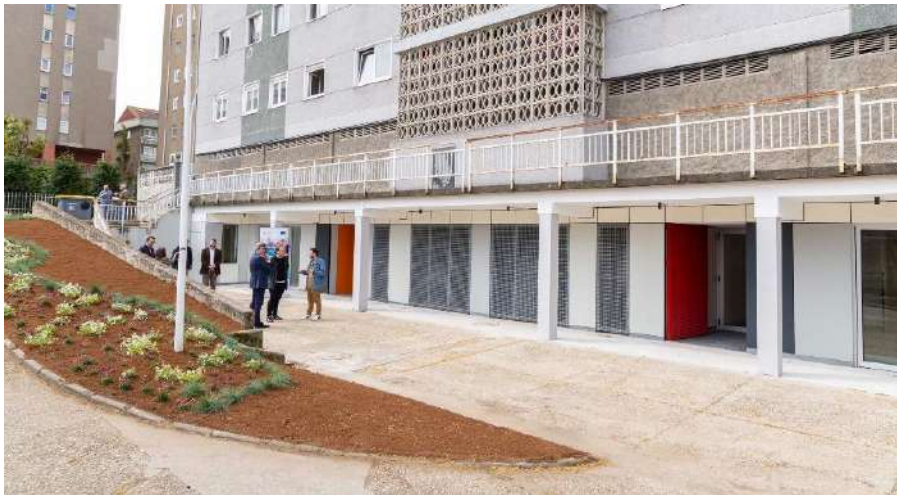
Imágenes del centro García Sabell durante y después de la obra de la reforma
