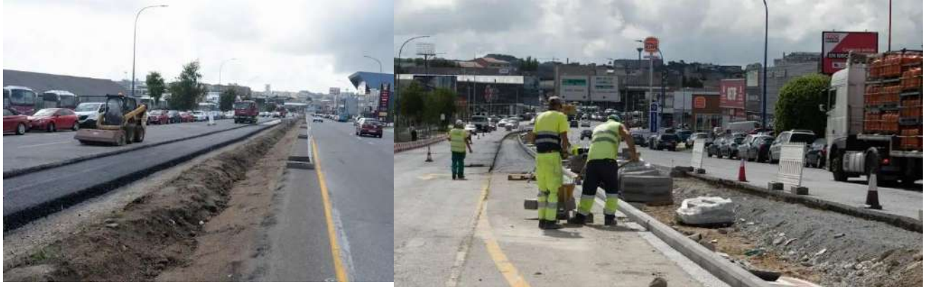
Obras de la actuación humanización y reurbanización de la calle Severo Ochoa.
