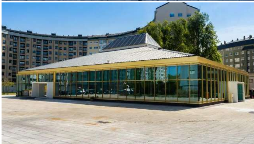
Imágenes del exterior del mercado de Adormideras antes y después finalizada la actuación
