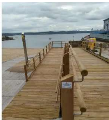
Pasarela San Amaro
