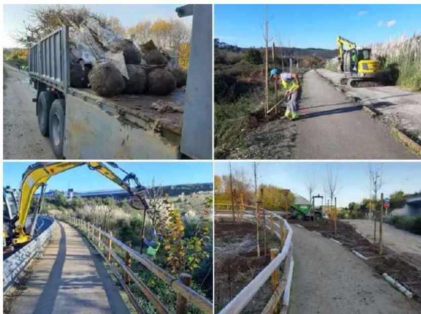
Obras de recuperación de caminos tradicionais
