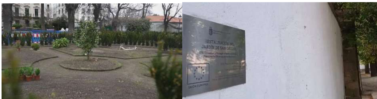
Imágenes de la obra de mejora integral del Jardín de San Carlos y la placa permanente
