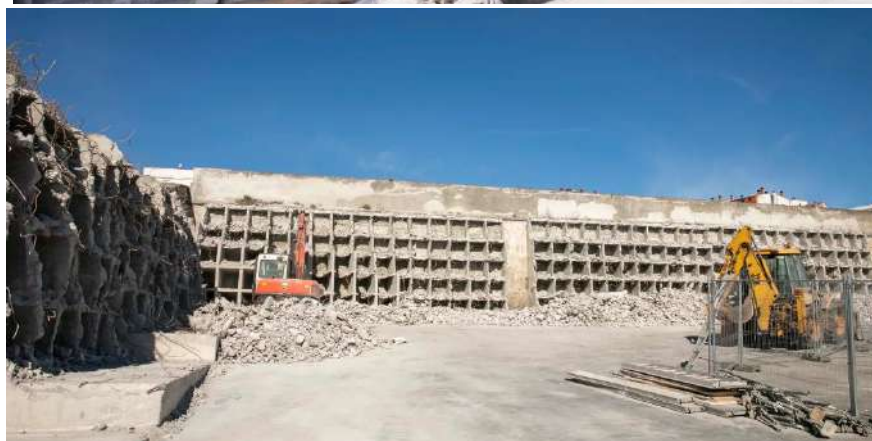
Imágenes de las obras del cementerio de San Amaro (Acondicionamientos varios)
