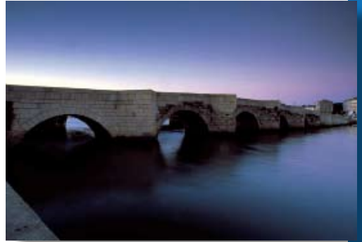
Vista de la Ría del Burgo con el puente romano que la atraviesa
