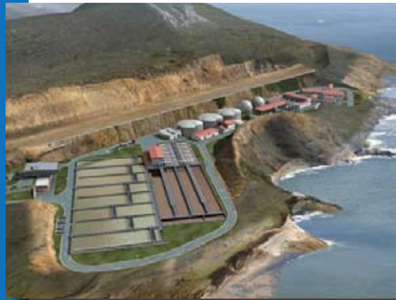
Vista de la depuradora de Bens
