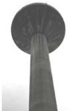
2. Depósito de Montealto
